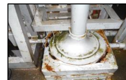
【給油施設の更新】
