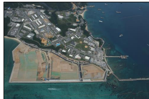
【普天間飛行場代替施設の建設】
