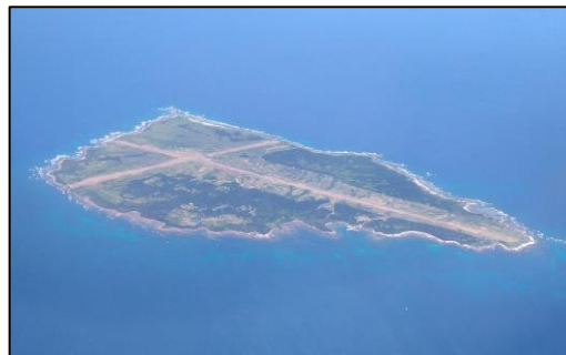
【馬毛島における施設整備】
