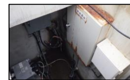
【地下変電施設の更新】
