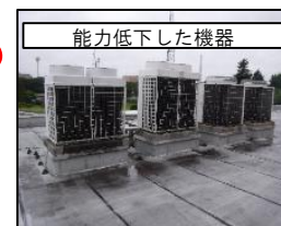
【空調機の更新】
