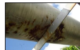
【燃料配管の更新】
